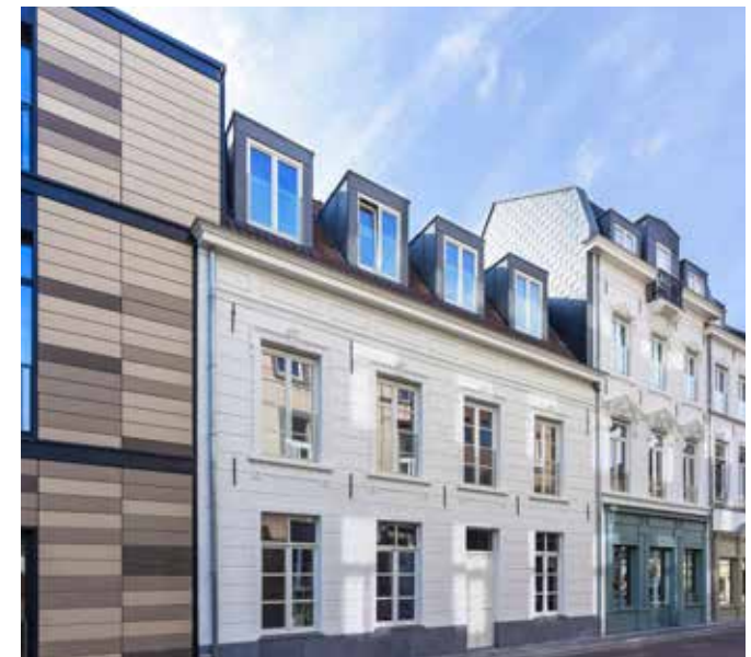
Vesalius omvatte zowel nieuwbouw als restauratie. Enkele bestaande 17e- en 18e-eeuwse gevels moesten in ere hersteld worden, om ze vervolgens naadloos te integreren in de nieuwe ontwikkeling.
