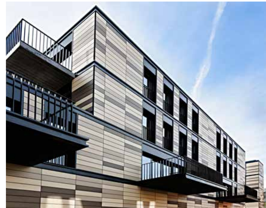
De gevelbekleding bestaat niet uit monochroom metselwerk, maar uit vlakke, keramische platen in drie zandkleurige tinten.
